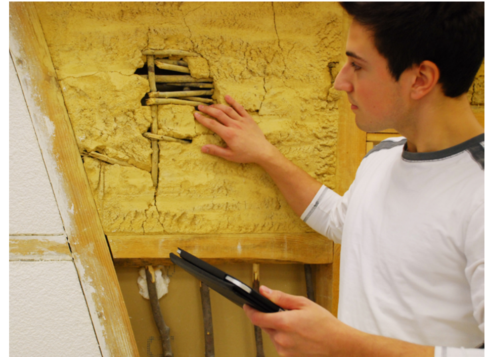
Auszubildender prüft Fehlstelle im Geflecht eines Fachwerks (Bild: Stephan Bacher, Fachverband der Stuckateure für Ausbau und Fassade)
