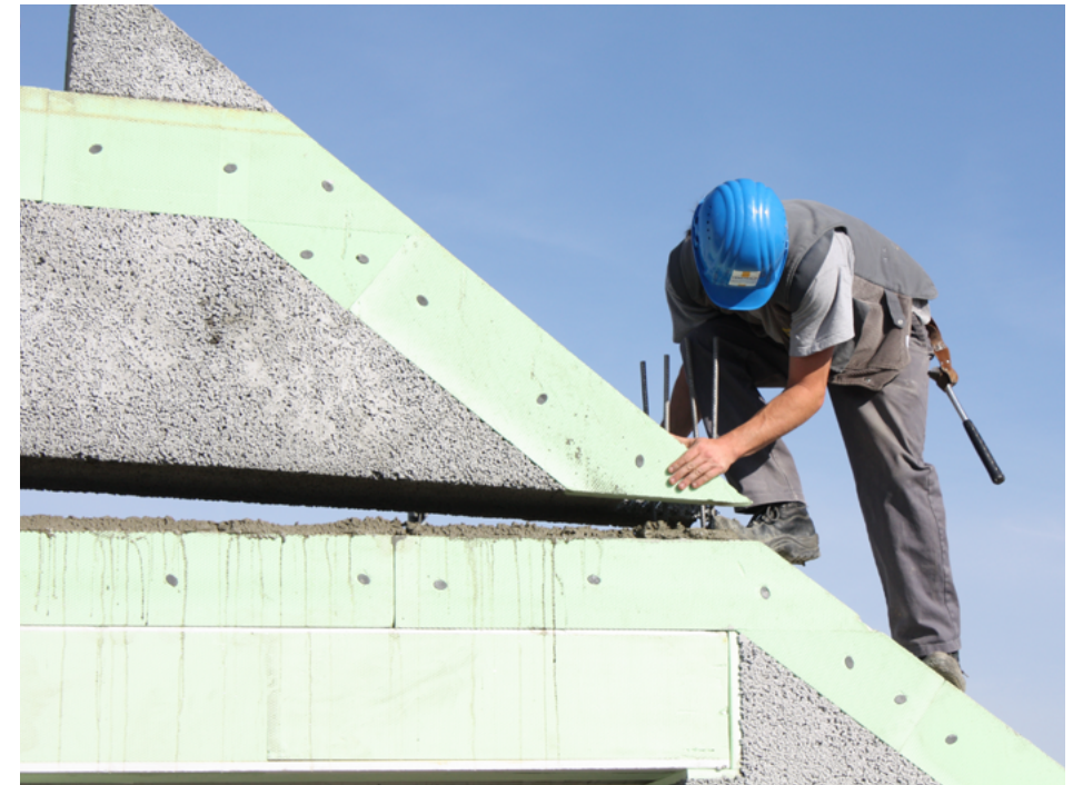
Montage von vorgefertigten Bauelementen (Bild: Komzet Bau Bühl)
