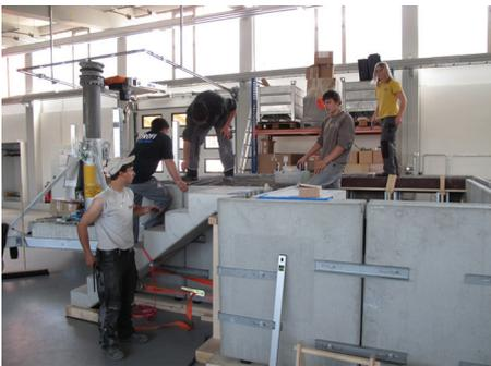
Ausführung eines wasserundurchlässigen Kellers mit Elementwänden in der Ausbildung, Foto: ABZ Bühl
