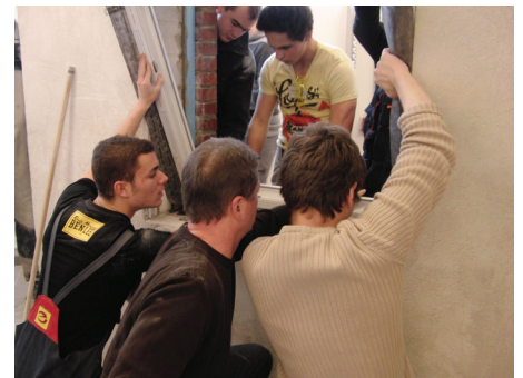
Gemeinsamer Fenstereinbau an Gewerkeschnittstellen Foto: AZB-Hamburg
