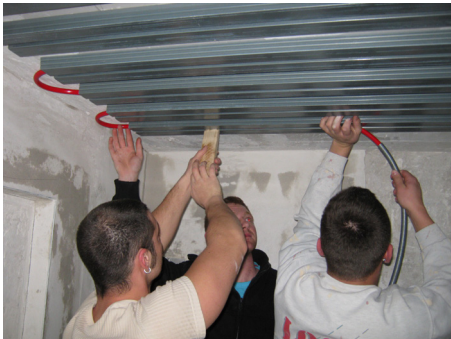
Montage einer Klimadecke Foto: Kompetenzzentrum Ausbau und Fassade
