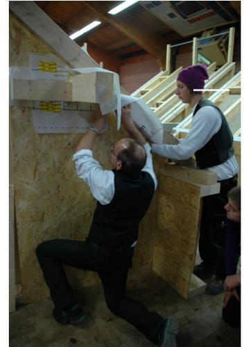
Luftdichter Anschluss von Mittelpfette an Dach und Wand
